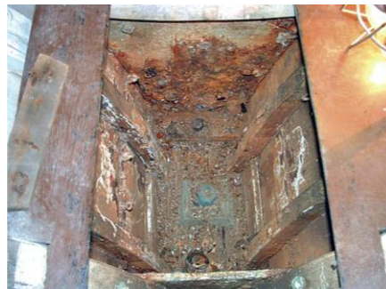
Sieht nicht gut aus, wenn Eisen im Holz korrodiert. Oben ein Stumpfbolzen, Blicke in die Bilge mit Stahlbodenwangen und Spanten aus Metall. Von außen ist die für die Festigkeit gefährliche Korrosion in der Regel nicht zu erkennen.
