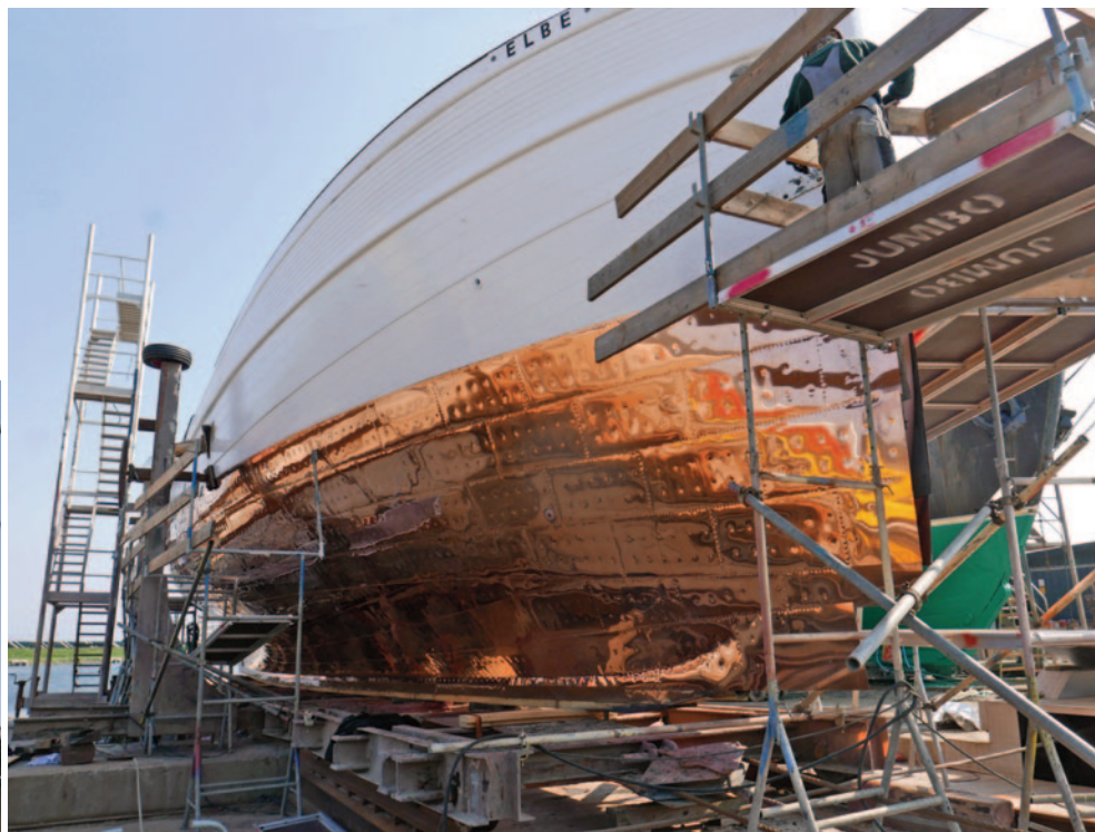
Kupferbeschlagen des Unterwasserschiffs des „Lotsenschoners No.5 Elbe“.
