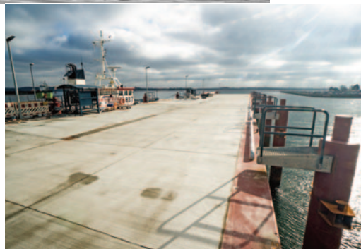
Pier mit Werftkran Anfang-Mitte der 1930er Jahre (oben). Die gerade fertiggestellte innovative Hybrid-Pier 5160-2 (unten).
